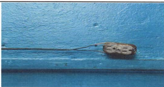
Foto 5: cambio de tomacorrientes
