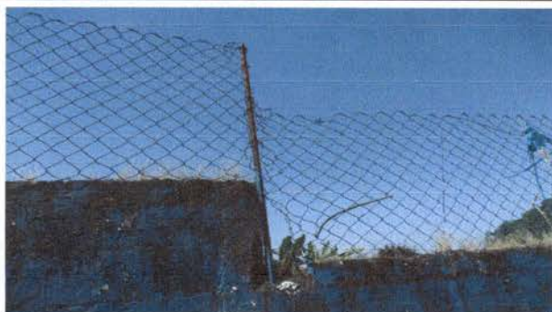
Foto 3: Reparación de enmallado
