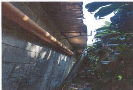
Foto1: Sustrucción de Canal
