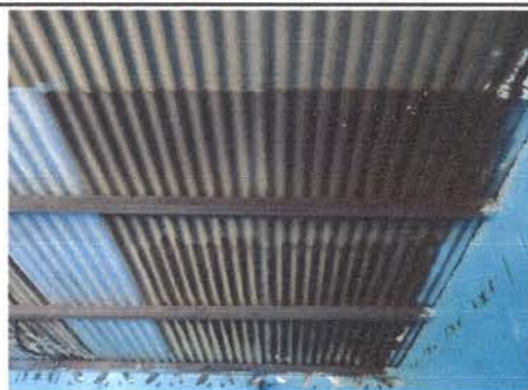
Foto 5: cambio de laminado
