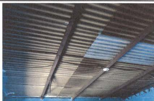
Foto 4: Cambio de laminado
