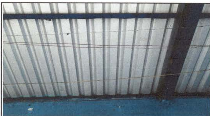
Foto 4: Cambio y entubado de cableado eléctrico
