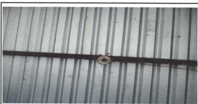
Foto 6: cambio de plafoneras
