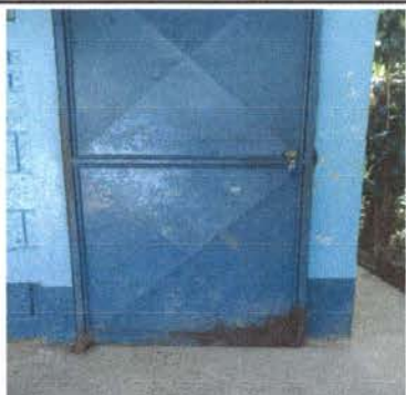
Foto 3: sustitución de puerta
