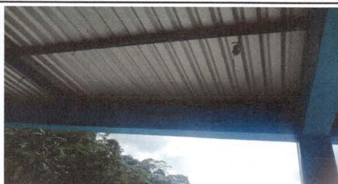
Foto 2: Sustitución de lamparas en los corredores
