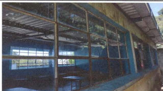
Foto 2: colocación de blacones
