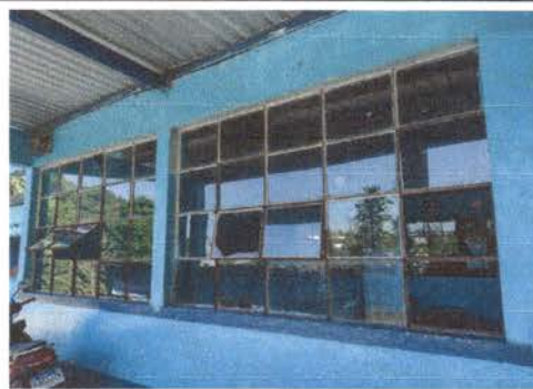
Foto 6: Colocación de balcones
