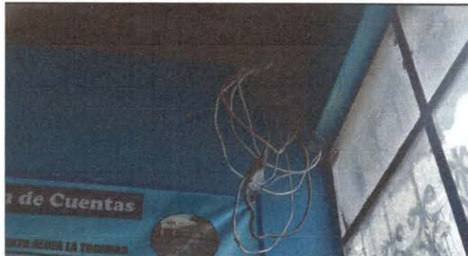
Foto 4: cambio de cableado electrico
