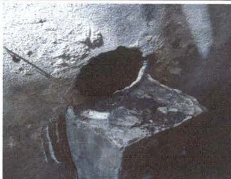
Foto 1: reparación de chimenea
